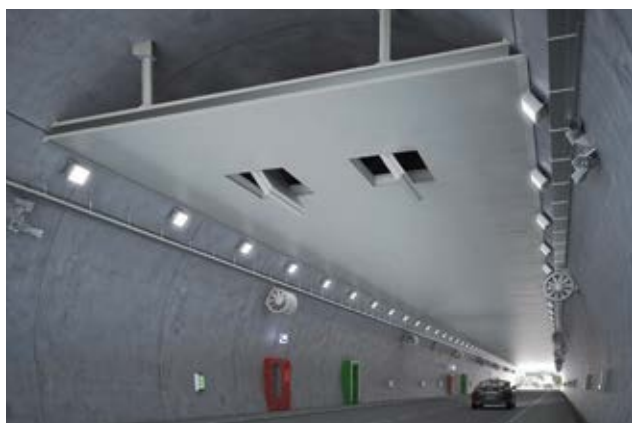
Nachträglich montierte Entrauchungsdecke
