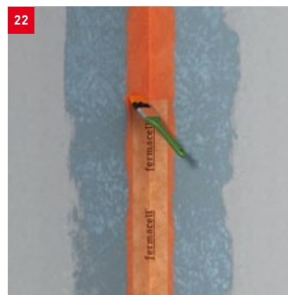
Erneut mit fermacell™ Flüssigfolie überstreichen
