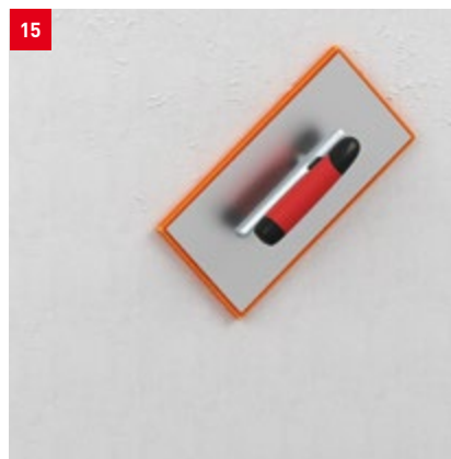
Abfilzen des fermacell™ Leichtmörtels HD
