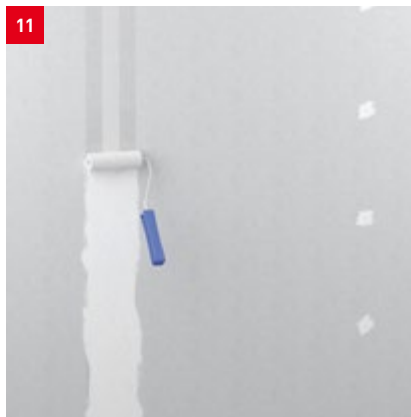
Aufbringen des fermacell™ Armierungsklebers HD
