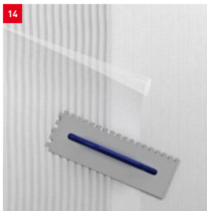
Überlappung der Gewebeklebebahnen
