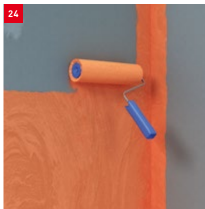
fermacell™ Flüssigfolie mit der Rolle 2×vollflächig auftragen
